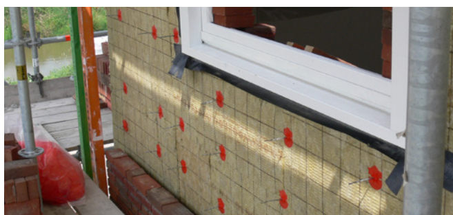
Priksouwanker met UNI-CLIP
